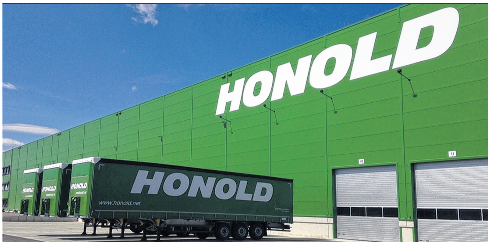
Weithin sichtbar: Das neue Logistikzentrum in Oberkochen hat etwa vier Millionen Euro gekostet.
